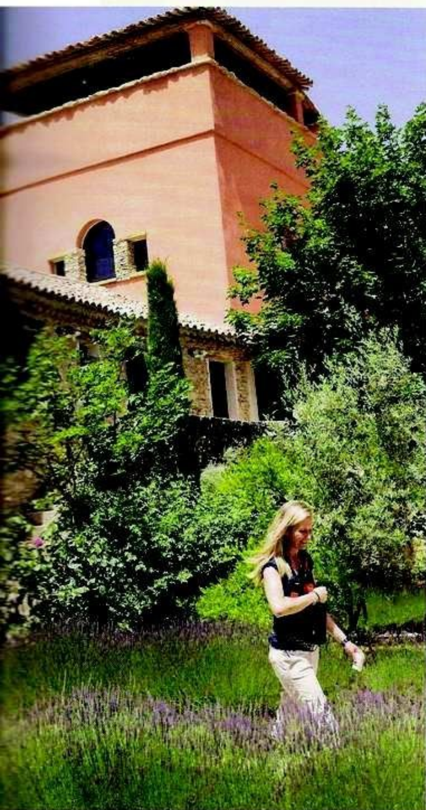
Au domaine de La Croix, l'ancienne ferme a été restaurée et de vastes chais souterrains créés (ci-contre). Soledad Tari dans son domaine de La Bégude (ci-dessus).
